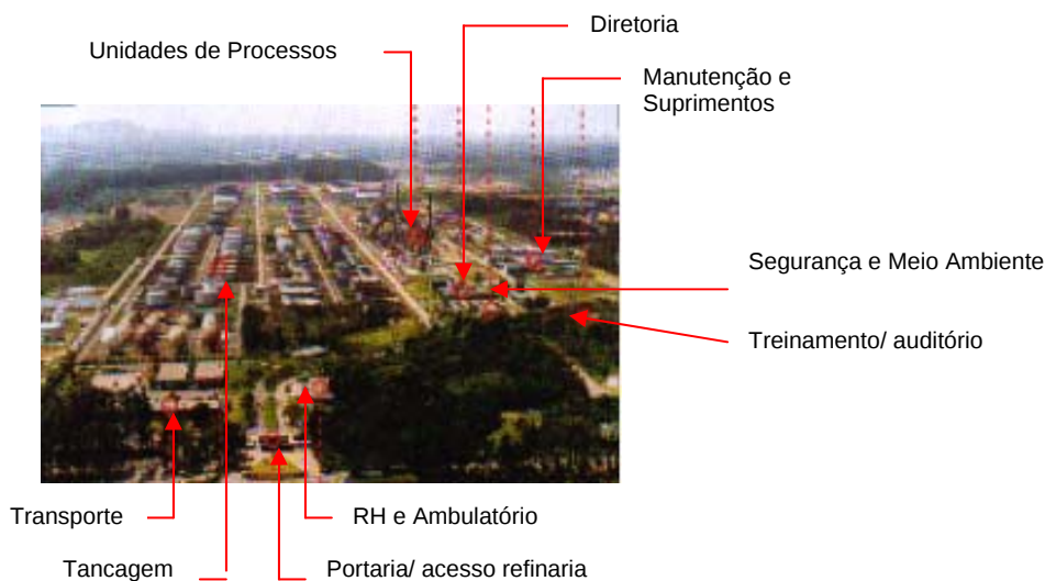
Figura 103: Foto aérea da refinaria
