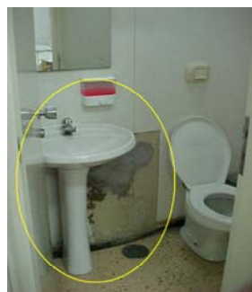
Figura 111: Sanitário da sala de recuperação
