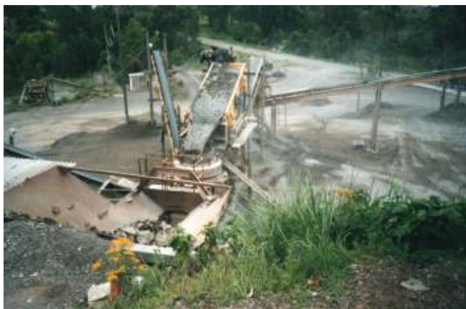
Figura 10 Foto Visão Geral da Instalação de Britagem
