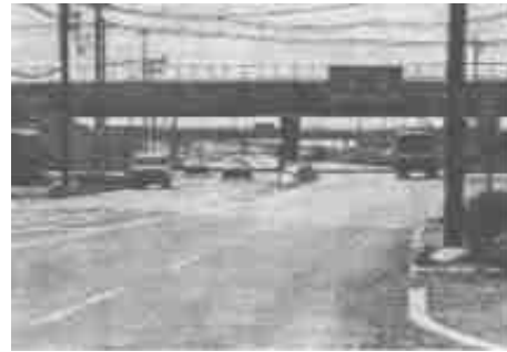
Figura 13: Obstrução central em uma rodovia de pista dupla convencional (TRB, 2000, Ilustração 12-5, p. 12-4)
